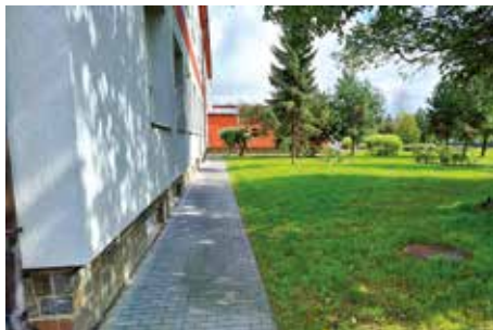
Oprava u Základní školy
