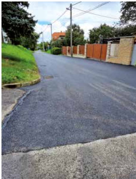
Oprava Bociánovy ulice
